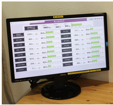
電力使用状況を示すモニター
