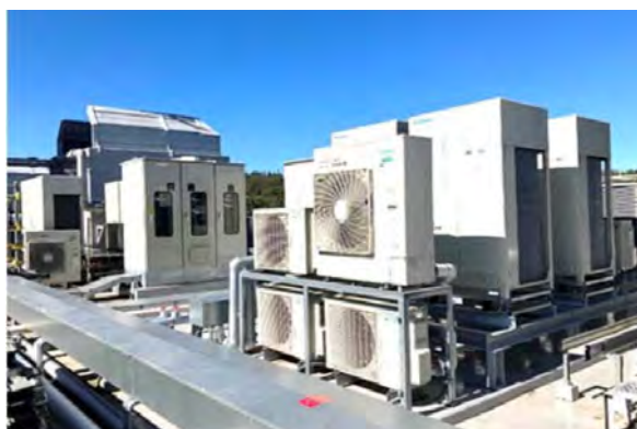
研究1・2号館改修工事
