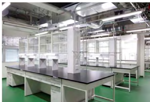
研究1・2号館改修工事
